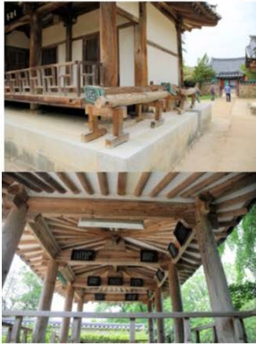
Gyeongnyeonjeong pavilion 修理によって垂木がほとんど取り替えられている。 Most of rafters of this building have been replaced after the repair work.
